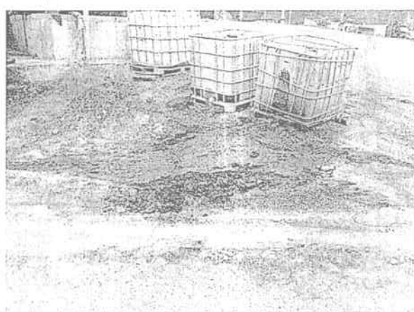
Fotografía No. Evidencia de derrame de mezcla asfáltica que genera riesgo de afectacion al suelo y al embalse del Guajaro (por escorrentías).
